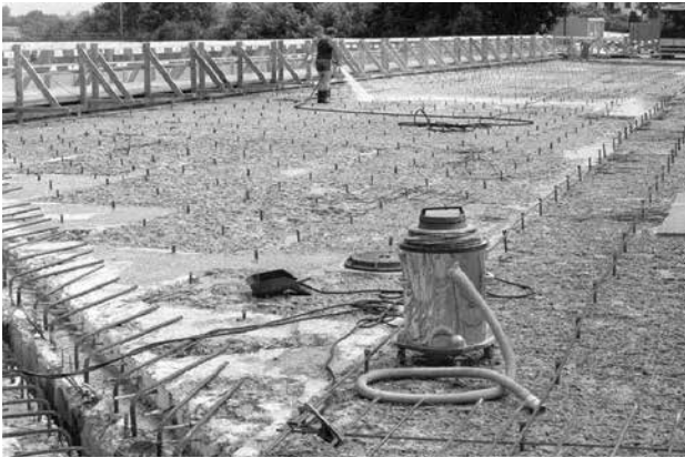
Conexiones colocadas como preparación para una nueva losa estructural de cubierta
